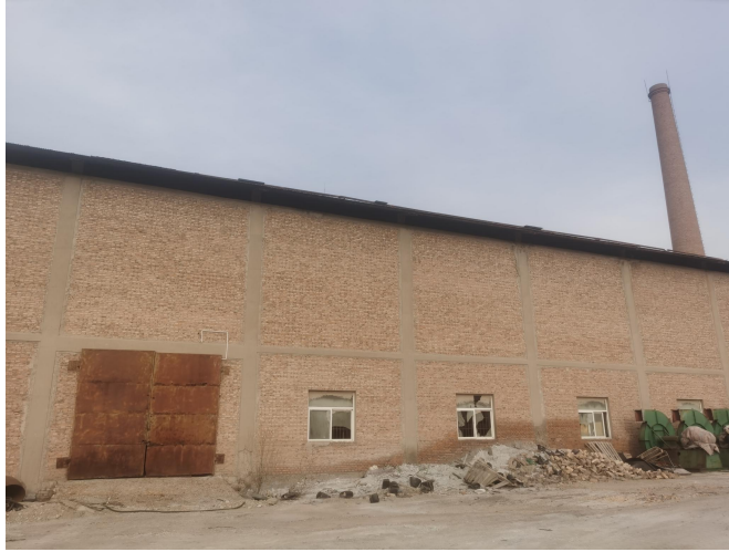
图 2-3 本项目租赁厂房现状
